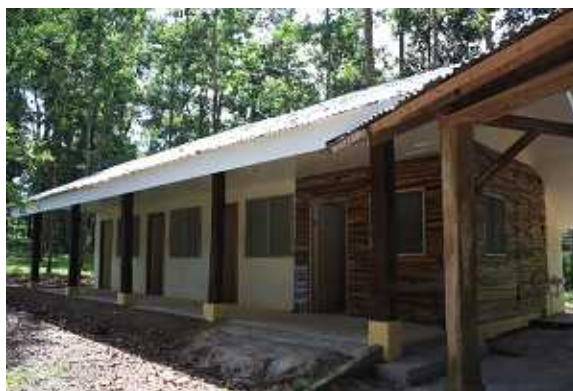
全部で四部屋あります。手前の部屋はトイレ付、この建物の後ろにトイレが二つ、台所もあります。
